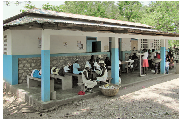
Figure 1 Bâtiment d'un dispensaire.
