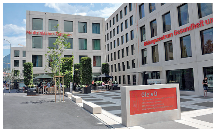
Figure 3 Le MeZ de Coire – de grandes fenêtres sont les éléments dominants des façades du nouveau complexe.
