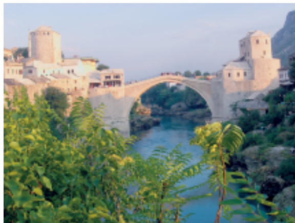
Abbildung 3 Die neue Brücke ...
